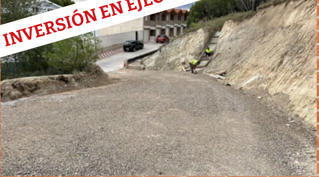
Construcción de accesos
