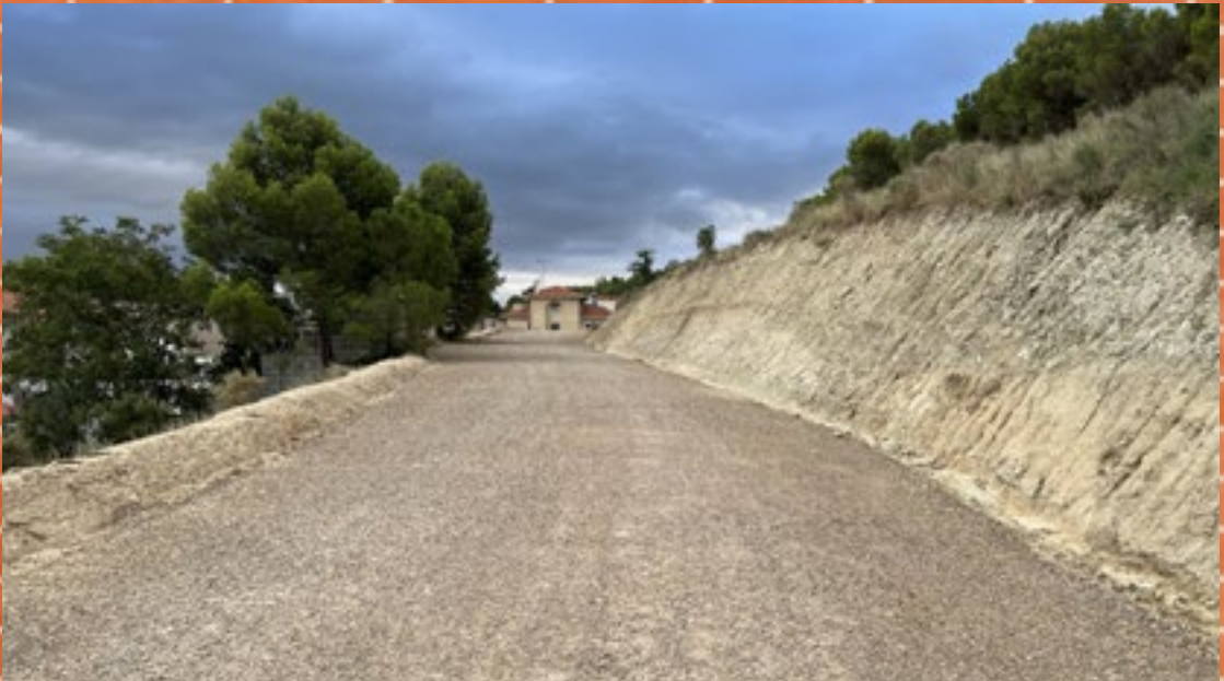
Construcción de accesos
